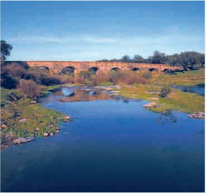
Puente de la Boñaga sobre el río Alcarrache
